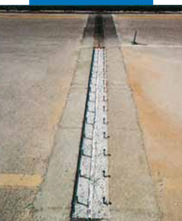
Autópályahíd merev csatlakozásának javítása Mapefill-lel
