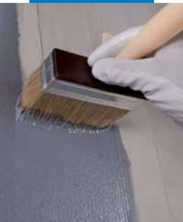
Eco Prim Grip felhordása ecsettel betonfalra
