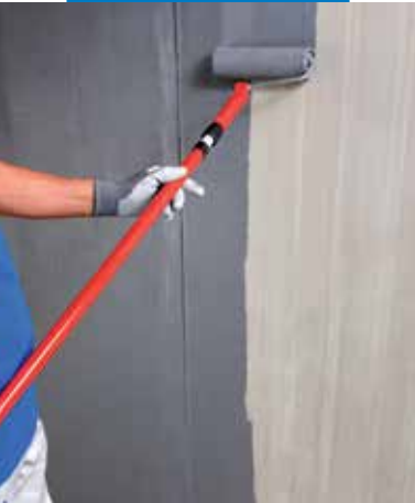
Eco Prim Grip felhordása hengerrel betonfalra
