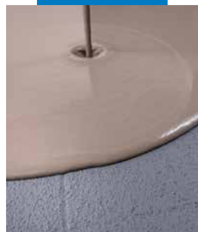
Ultraplan önterülő aljzatkiegyenlítő simítóhabarcsa bedolgozása a megszáradt Eco Prim Grip-re régi burkolaton
