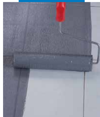
Eco Prim Grip felhordása hengerrel meglévő greslap burkolatra
