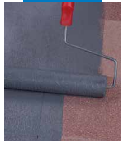
Eco Prim Grip felhordása hengerrel meglévő terrazzo padlóburkolatra
