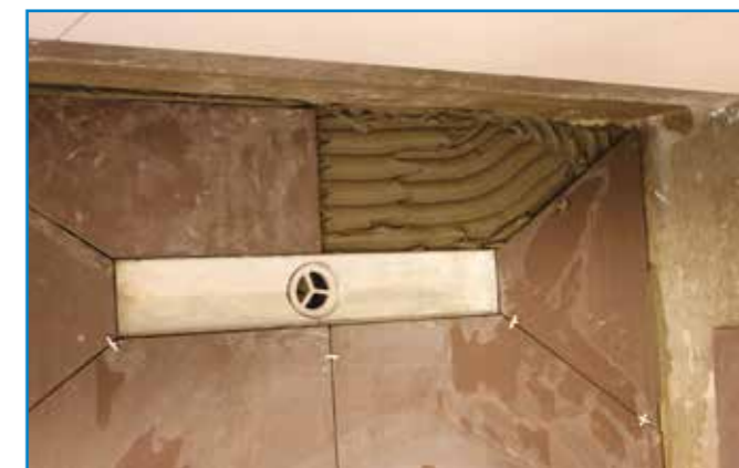
Fugakereszt használataival biztosítható a lapok precíz illesztése.
