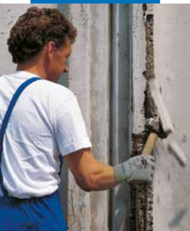
Sérült beton lebontása
