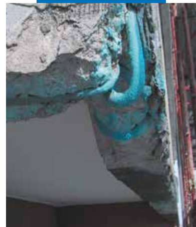
Mapefer 1K-val kezelt betonacélok az erkély homlokfelületén
